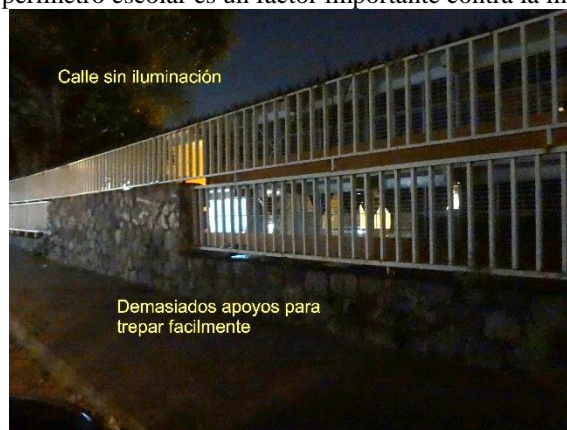
Figura 2. La iluminación del perímetro escolar es un factor importante contra la inseguridad. Esc. López Mateos.
