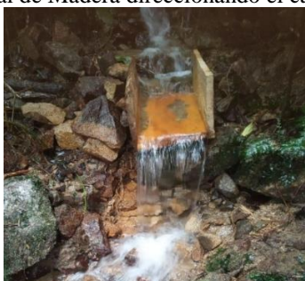
Figura 8 Canal de Madera direccionando el caudal existente
