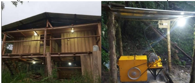
Figura 12 Pruebas del servicio eléctrico en el sector la esperanza
